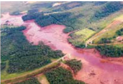
Luftbildaufnahme aus einem Video: die durch Eisenoxid rot gefärbte Schlammflut bei der zerstörten Eisenbahnbrücke, 26. Januar 2019 © TV NBR, CC BY 3.0, https://commons.wikimedia.org/w/index.php?curid=76122790
